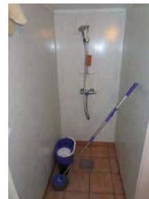
Dusjnise med lokalt fall til sluk.
