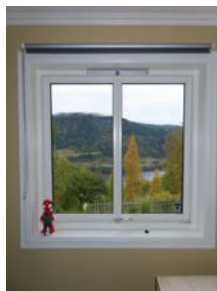
Åpningsvindu med luftespalte i overkarm.
