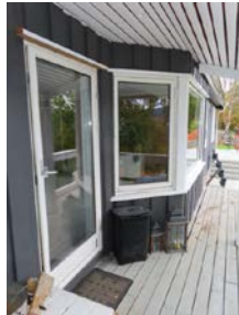
Overbyggt del av terrasse/veranda ut for stue med enkeltfløyet terrassedør samt vinduer i karnappen.
