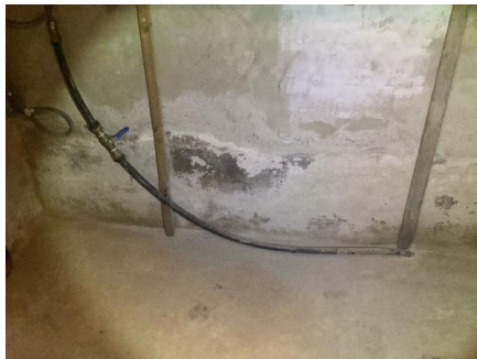
Stikkledning til låve.
