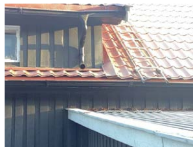
Stedvis enkel utførelse av beslagsarbeid.
