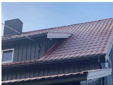
Beslag mellom tak og takløft er lagt utenpå kledning.
