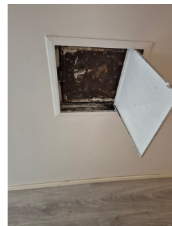
Sotluke bak inspeksjonsluke av plast.
