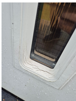
Værslitte glasslister til kjellerdør.
