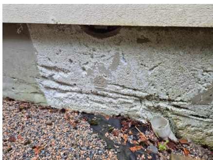
Ikke pusset utenfor inngangspartiet.
