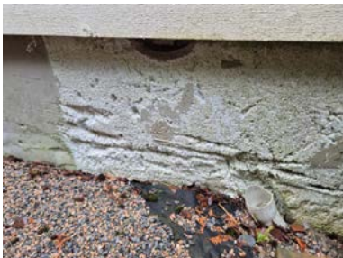
Ikke pusset utenfor inngangspartiet.
