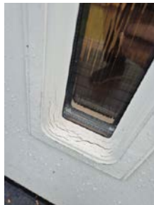
Værslitte glasslister til kjellerdør.
