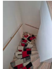
Mangler håndløper på en side og for lavt rekkverk.
