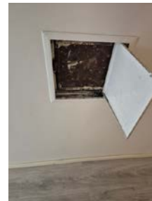
Sotluke bak inspeksjonsluke av plast.
