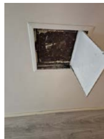
Sotluke bak inspeksjonsluke av plast.
