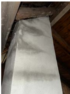
Pipe på loft har fire synlige sider.
