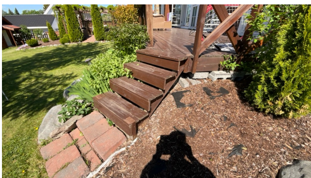
Trapp ned fra terrasse
