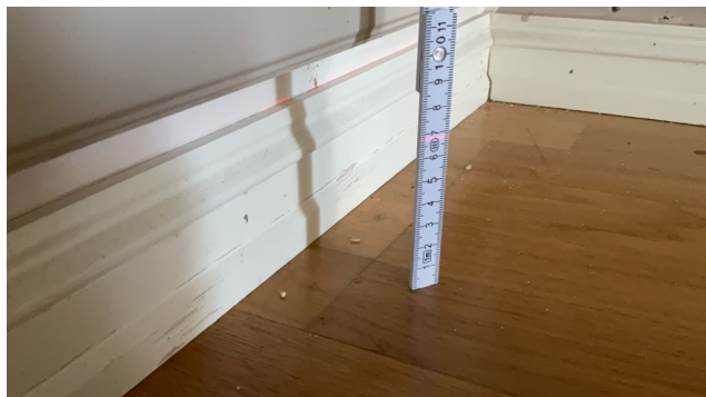
Gulv på kjøkken i hybel, mot innredning.
