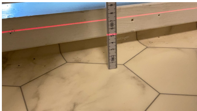
Høyde gulv ved dør
