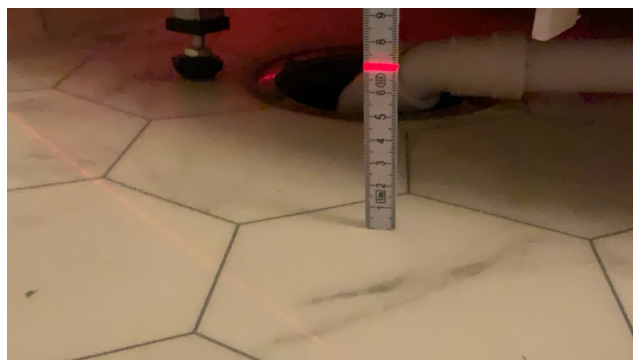
Høyde i forkant av sluk.
