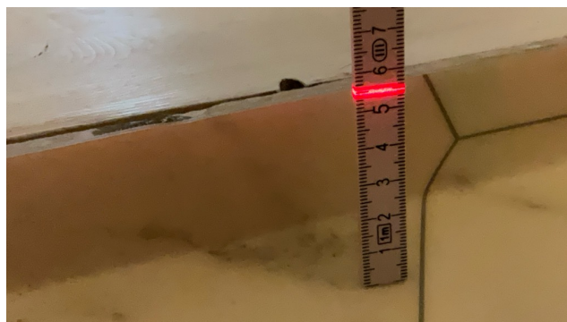
Høyde gulv ved dør.
