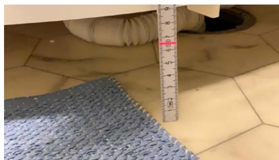
Høyde forkant sluk.
