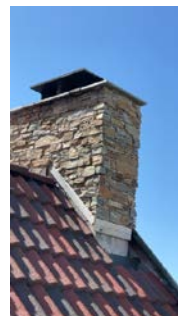
Pipe på tilbygd del mangler beslag.
