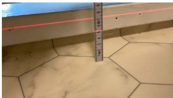
Høyde gulv ved dør
