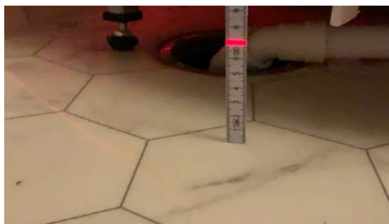
Høyde i forkant av sluk.
