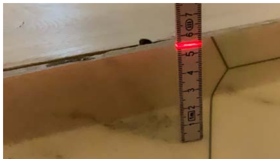
Høyde gulv ved dør.
