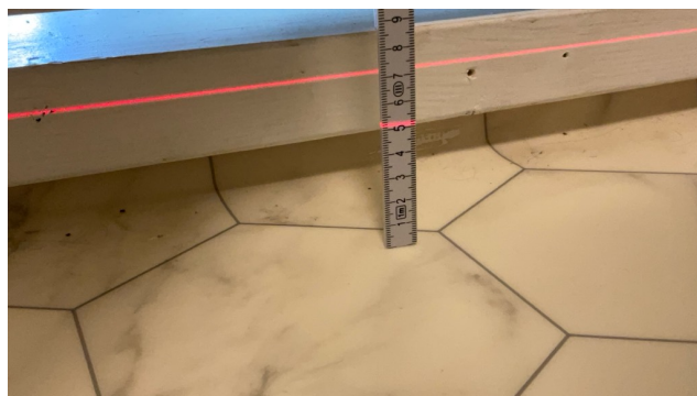
Høyde gulv ved dør
