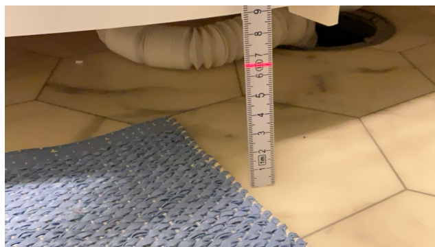
Høyde forkant sluk.
