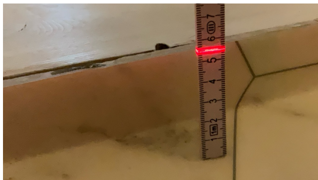
Høyde gulv ved dør.
