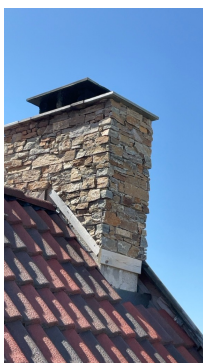
Pipe på tilbygd del mangler beslag.
