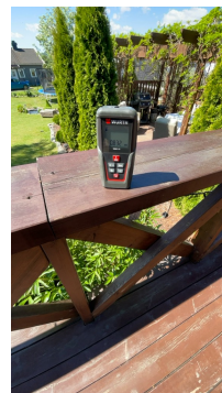
Rekkverkshøyde terrasse i 1. etg. 83 cm.
