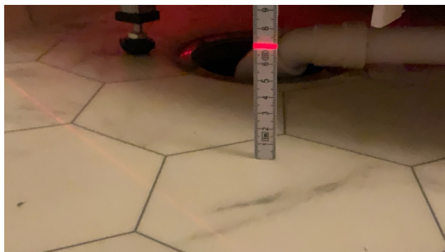
Høyde i forkant av sluk.
