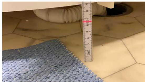
Høyde forkant sluk.
