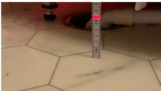
Høyde i forkant av sluk.
