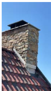
Pipe på tilbygd del mangler beslag.
