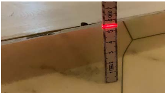
Høyde gulv ved dør.
