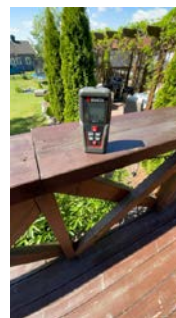
Rekkverkshøyde terrasse i 1. etg. 83 cm.
