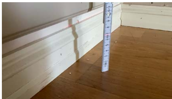
Gulv på kjøkken i hybel, mot innredning.
