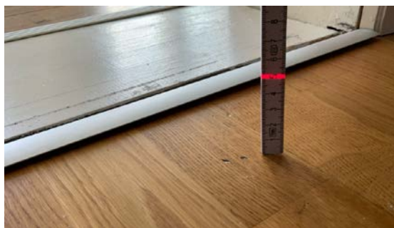
Gulv på kjøkken i hybel, åpning mot stue.
