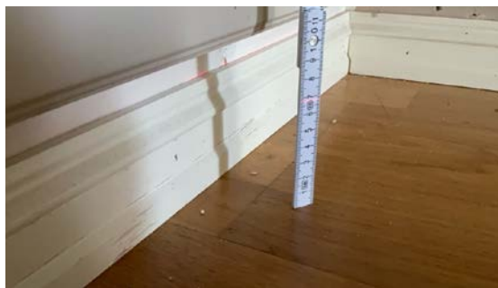
Gulv på kjøkken i hybel, mot innredning.
