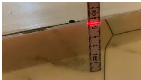
Høyde gulv ved dør.
