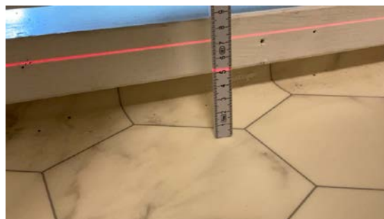
Høyde gulv ved dør
