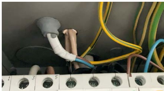
Utett gjennomføring.
