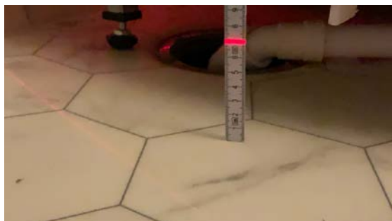
Høyde i forkant av sluk.
