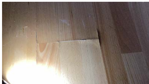
Svelling i laminatgulv
