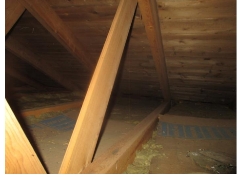
Tynt lag med isolasjon i mot kaldtloftet.
