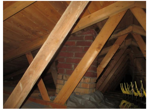
Deler av undertaket.
