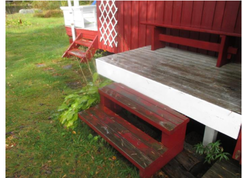
Enkel trapp til platting ved inngangsparti.
