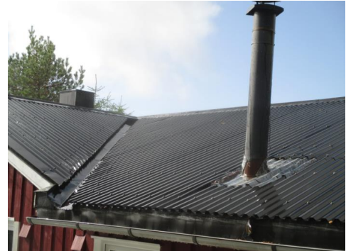
Deler av taktekkingen.
