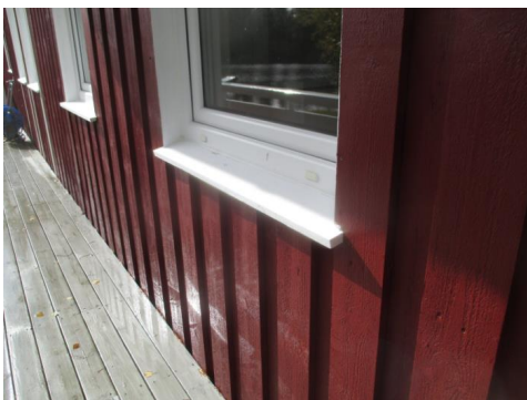
Deler av kledningen med tilhørende belistninger. Dekke på terrasse ligger inntil kledningen.
