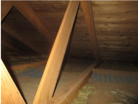
Tynt lag med isolasjon i mot kaldtloftet.
