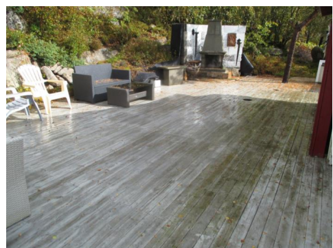
Større platting bak hytta.
