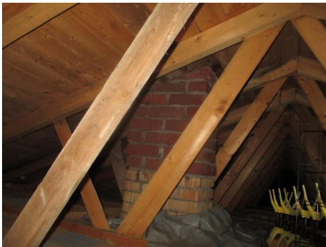
Deler av undertaket.
