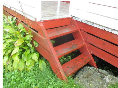
Enkel trapp til terrasse.
