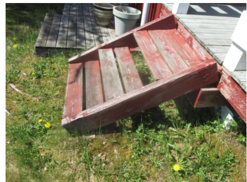
Trapp til terrasse.
