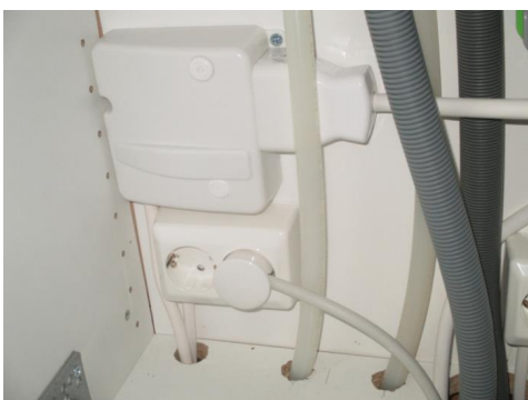
Plastrør i kjøkkenbenken.
