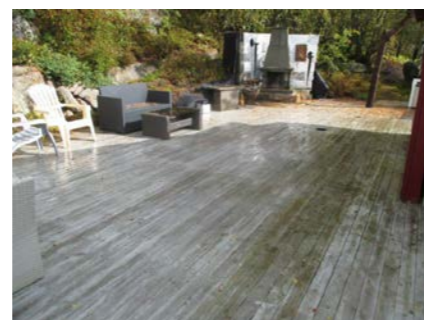
Større platting bak hytta.
