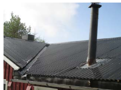
Deler av taktekkingen.
