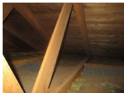
Tynt lag med isolasjon i mot kaldtloftet.
