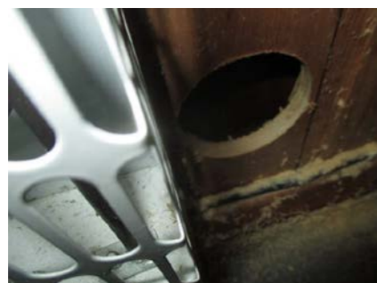
Hulltaking i fra teknisk rom/bod.
