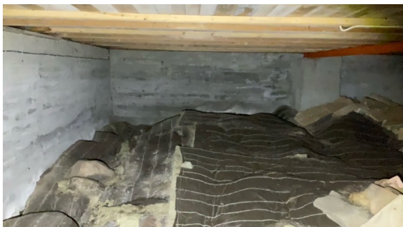
Gulv dekket med sydde isolasjonsmatter.
