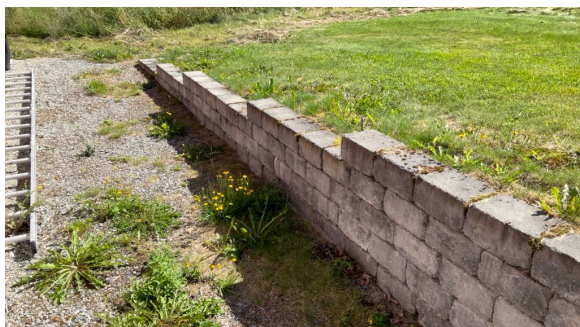
Støttemur ved garasjen.
