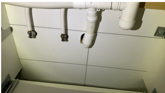
Utett rundt rørgjennomføring i vegg.
