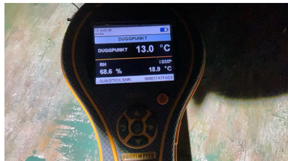
Krypkjeller er noe fuktigere enn resten av kjelleren
