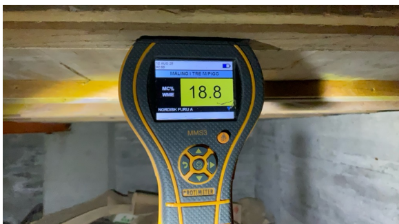
Fuktmåling i treverk.
