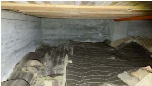
Gulv dekket med sydde isolasjonsmatter.
