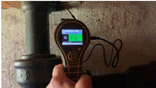
Fuktmåling i konstruksjon under sluken.
