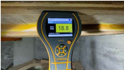
Fuktmåling i treverk.
