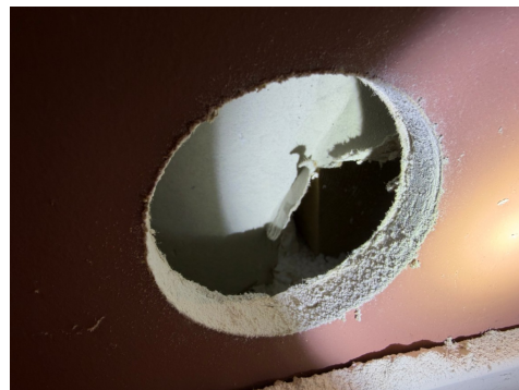
Synlig del av veggkonstruksjon etter hulltaking.
