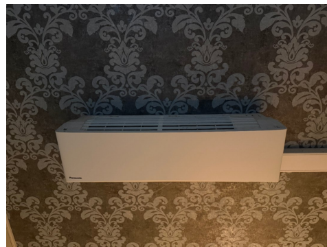
Varmepumpe med uttak i trapperom
