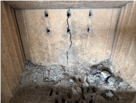
Sprekk i ildfast stein inni peisovn.
