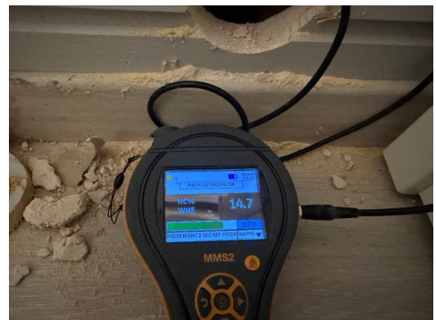
Måling av trefukt/vektprosent.
