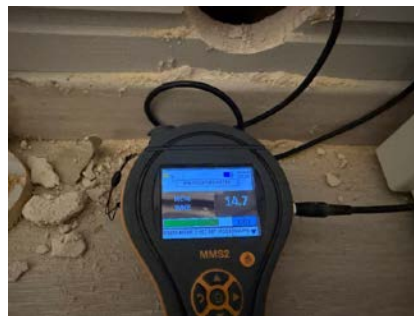
Måling av trefukt/vektprosent.
