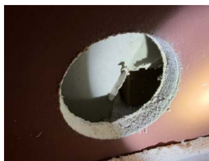
Synlig del av veggkonstruksjon etter hulltaking.
