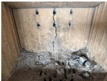
Sprekk i ildfast stein inni peisovn.
