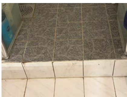
Oppkant til gulv i dusjsone.
