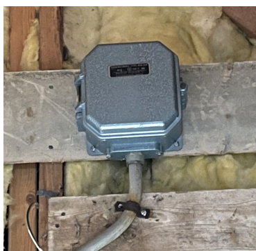
Inntakssikringer i boks på loft
