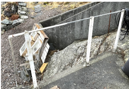
For store åpninger i metallrekkverk på betongterrasse
