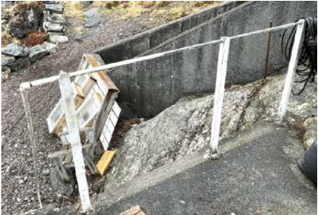
For store åpninger i metallrekkverk på betongterrasse
