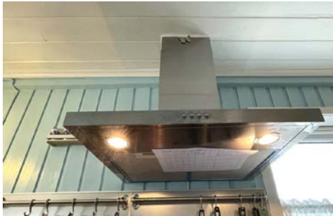
Ventilator bestod papirtesten.
