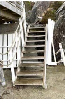
Tretrapp mot syd med taurekkverk
