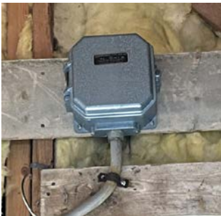
Inntakssikringer i boks på loft
