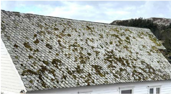
Takflate mot nord
