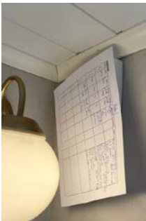
Avtrekksviften bestod papirtesten
