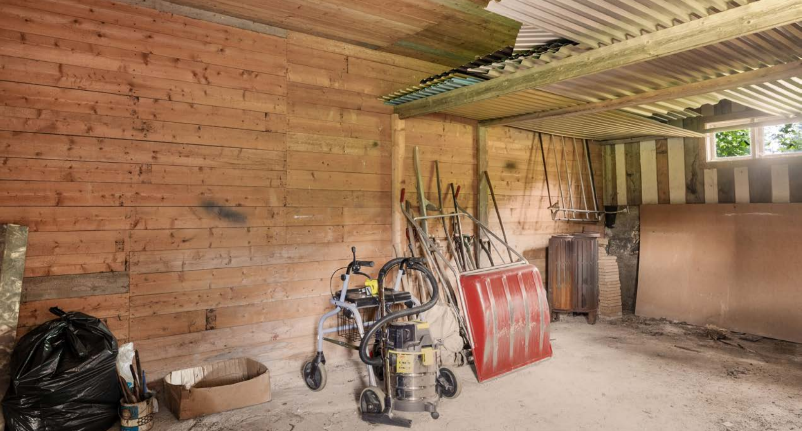
Gulvflater med lakkert tregulv, samt del med støpt gulv. Oppført i bindingsverk, antatt isolert med flis og innvendig kledd med panel og plater.
