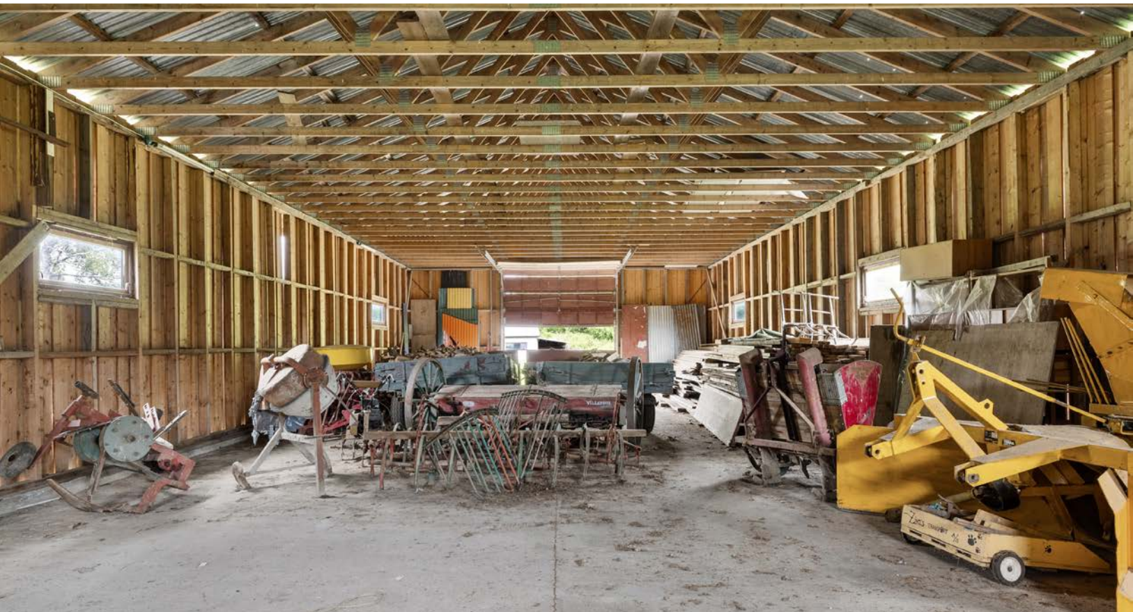
Låven har støpt plate på mark, vinduer med 2 lags isolerglass, montert leddport og skyveport.
