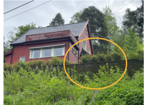
Støttemur uten sikring
