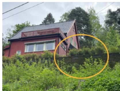
Støttemur uten sikring
