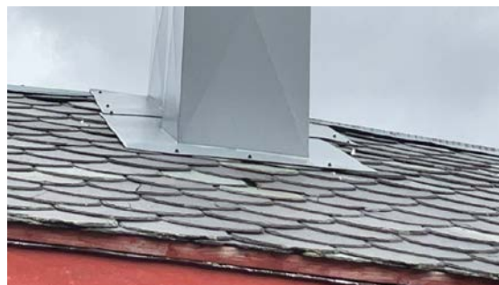
Sprekk i enkelte og stedvis knekte takstein
