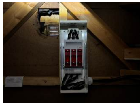
Inntaksikring på koffertloft.
