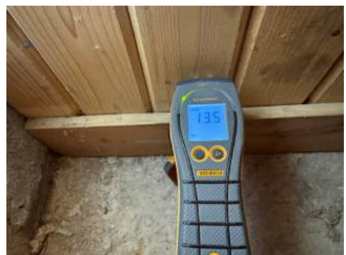
Måling av trefukt/vektprosent.
