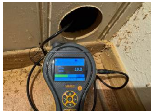
Måling av trefukt/vektprosent.
