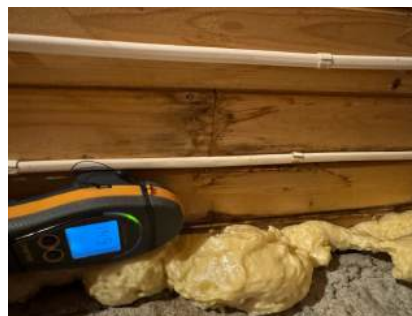
Eldre fuktmerker i bodhimling i u-etg. Ingen forhøyede fuktverdier ble registrert i det aktuelle område.
