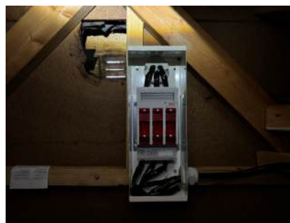
Inntaksikring på koffertloft.
