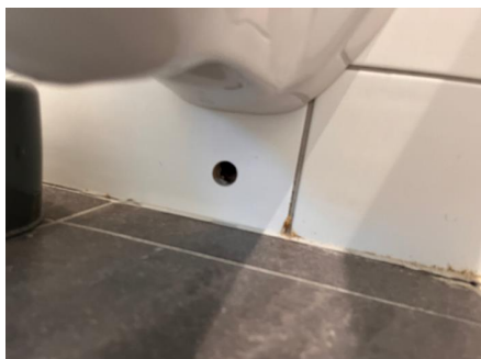
Drensåpning under innbygget vannsisterne
