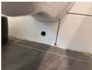
Drensåpning under innbygget vannsisterne
