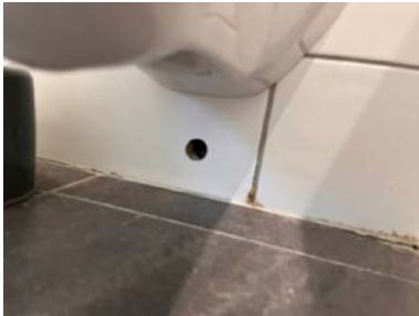
Drensåpning under innbygget vannsisterne
