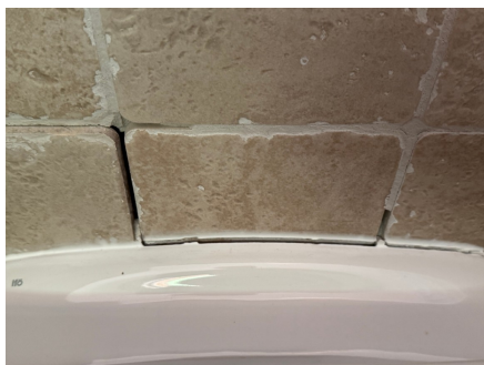
Bilde viser løse fliser / toalettskål
