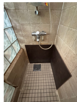
Bilde viser påskrudd plater i dusjsonen.
