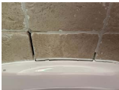
Bilde viser løse fliser / toalettskål
