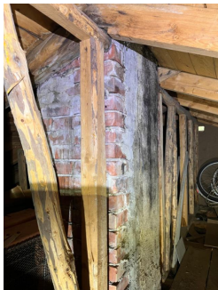
Eldre fuktmerker på bordtro og sperrer ved pipe
