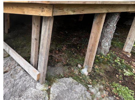
Understøtter på terrasse kun delvis montert på fjell
