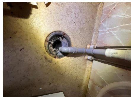
Sluk med avløp for skyllekar
