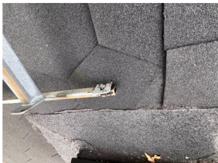
Papp er ikke fagmessig utført.
