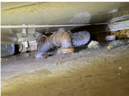
Rørgjennomføring for dusjkabinett
