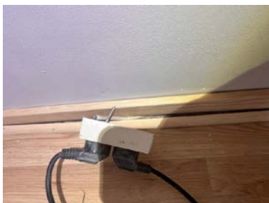
Ufagmessig utførelse, kabel bak gulvlist
