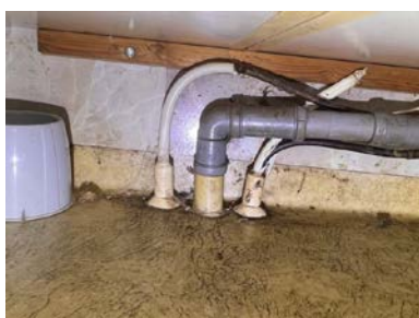
Rørgjennomføringer for servant
