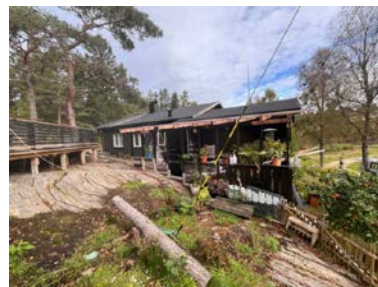
Fall inn mot grunnmur
