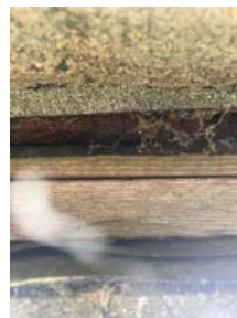
Lite lufting, ikke montert musesperre.
