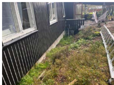
Fall inn mot grunnmur
