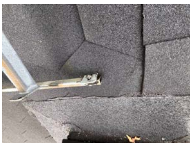
Papp er ikke fagmessig utført.
