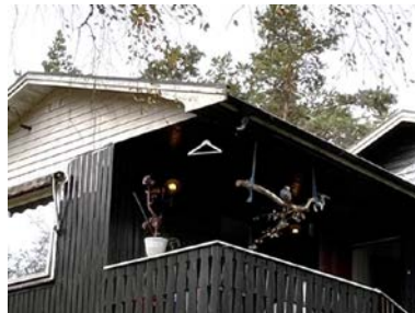
Det er ikke montert taknedløp
