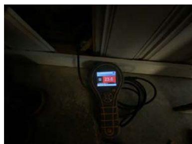
Fukt i utforet vegg i garderobe i underetasjen ved hovedvannrør.
