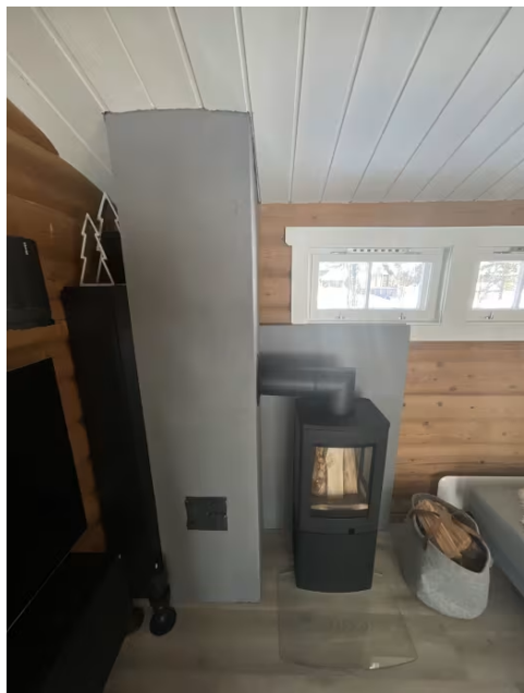
Viser ildsted og pipe i stue.
