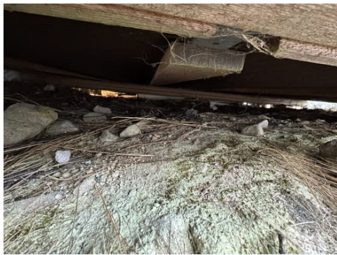
Deler av kryptkjeller med lav høyde mellom terreng og stubbloft.
