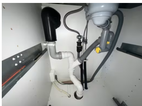
Viser vann og avløpsinnstallasjoner under kum. Lufting med vakuumventil.
