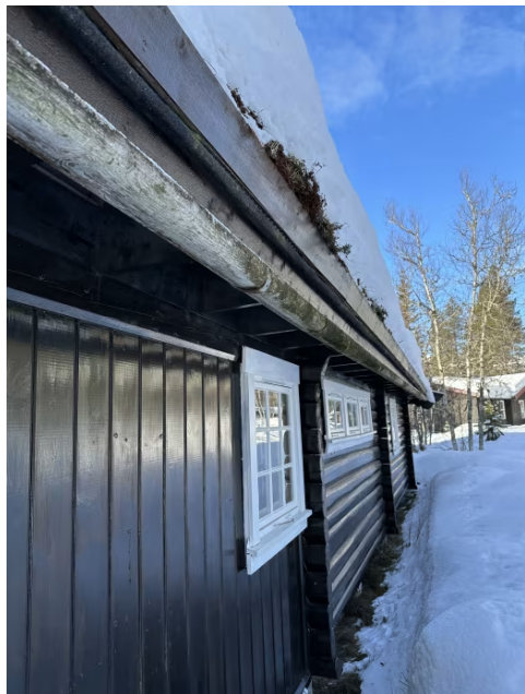
Viser takrenne i tre.
