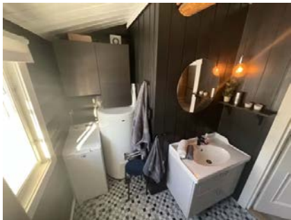
Viser baderomsinnredning, varmtvannsbereder og opplegg for vaskemaskin.
