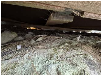
Deler av krypkjeller med lav høyde mellom terreng og stubbloft.
