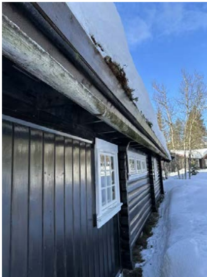
Viser takrenne i tre.
