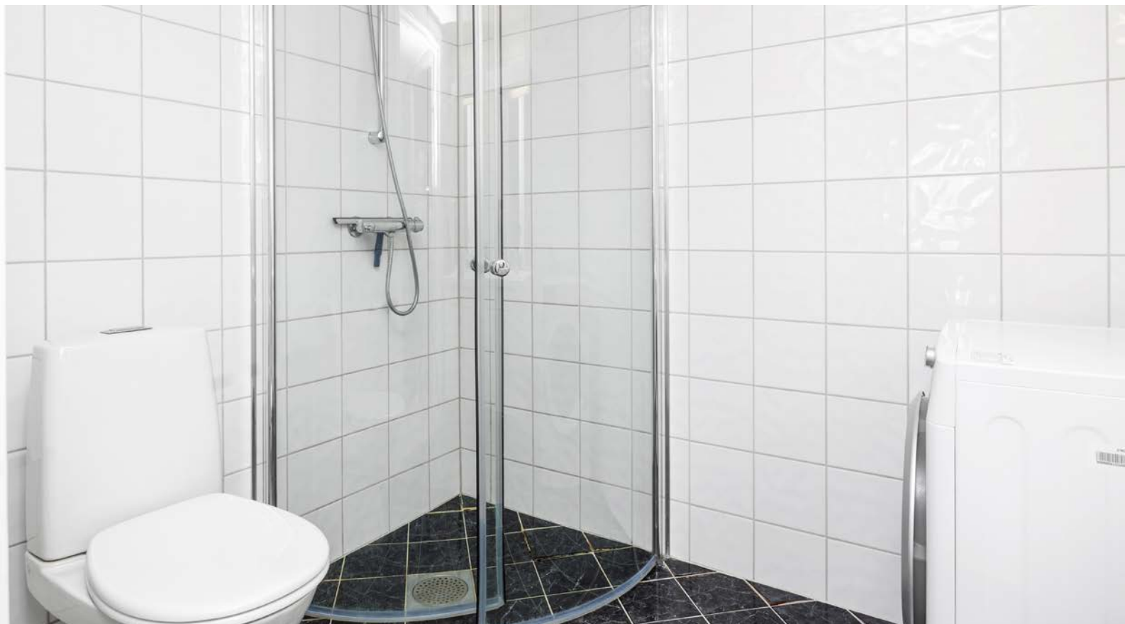
Badet har varmekabler i gulvet for ekstra komfort
