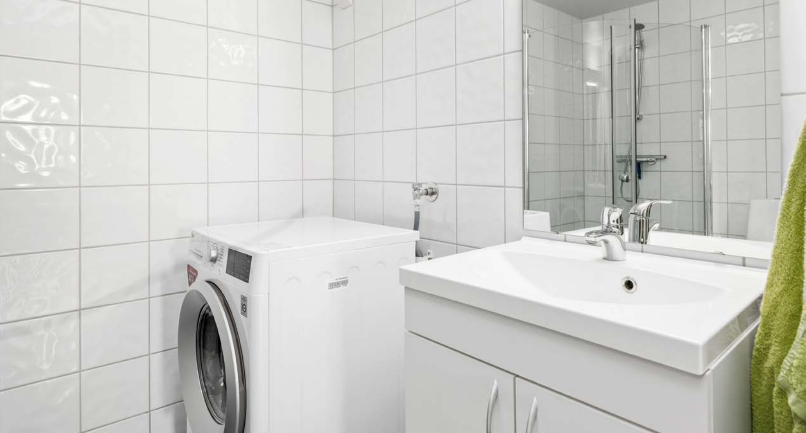
Flislagt bad med plass og opplegg for vaskemaskin
