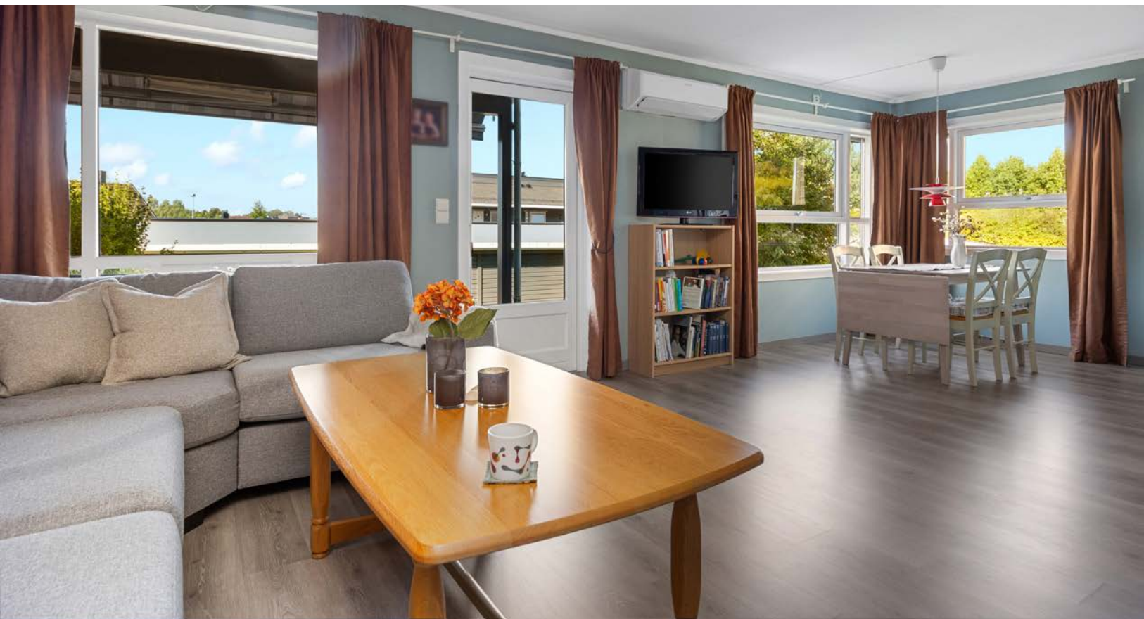
Det er installert luft-til-luft varmepumpe, og vinduene mot terrassen er utstyrt med utvendig solskjerming.
