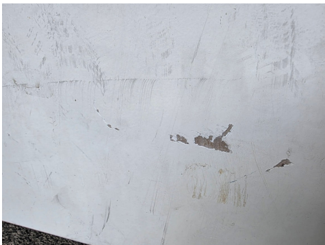
Skader på ytterdør
