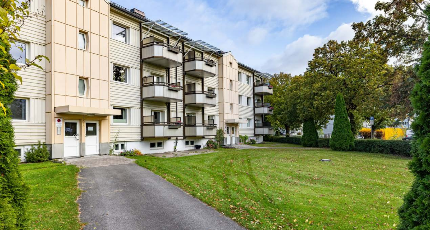
Borettslaget fikk nye inngangspartier og nytt porttelefonanlegg i 2011. Skiftet vinduer, terrassedører og ytterdører til oppgangene i 2011-2012.
