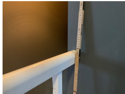
Høyde på rekkverk i 2. etg.
