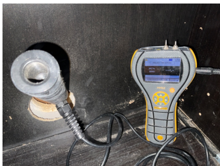
Fuktmåling i vegg ved hulltaking.
