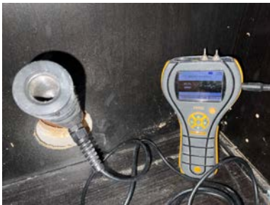
Fuktmåling i vegg ved hulltaking.
