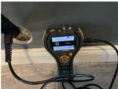
Fuktmåling i vegg ved hulltaking.
