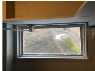
Eldre vindu i gang 1. etg
