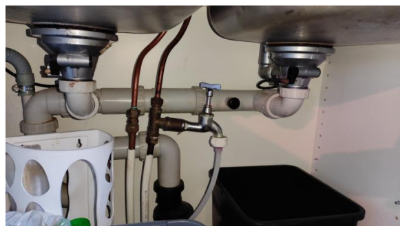
Kontroll av røropplegget.
