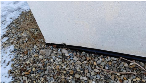
Synlig klemlist på grunnmursplast.
