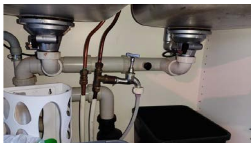
Kontroll av røropplegget.
