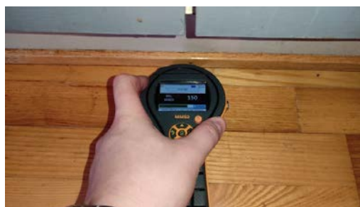
Fuktsøk ved oppvaskkum.
