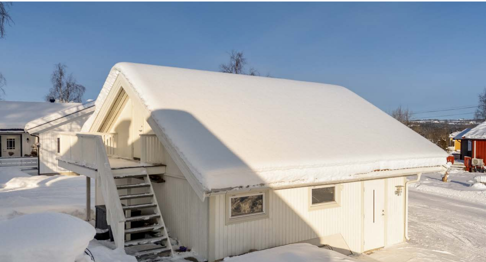
Trapp til innredet rom over garasjen.
