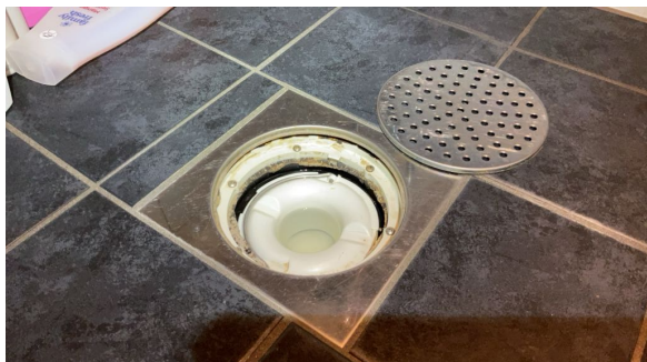
Kontroll av sluk.
