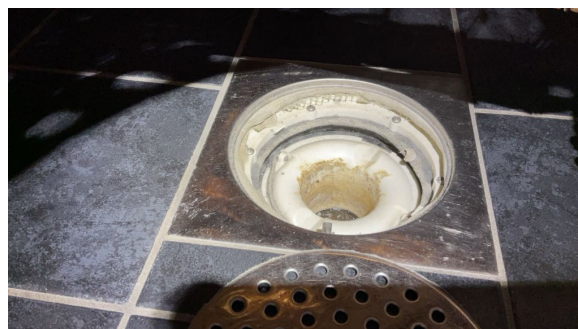
Kontroll av sluk.
