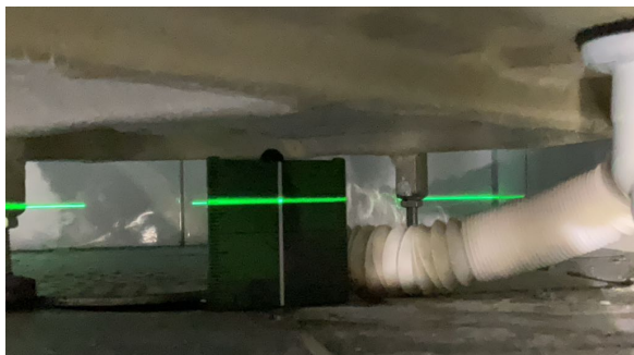
Målt fall til sluk: 15mm
