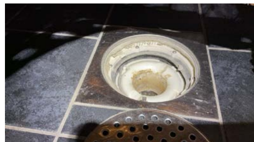
Kontroll av sluk.
