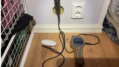
Hulltaking utført fra tilstøtende rom.
