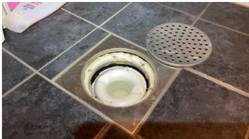
Kontroll av sluk.
