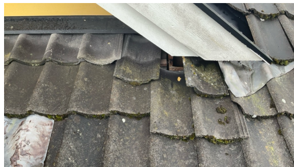
Utett løsning på tak mot tilbygg.
