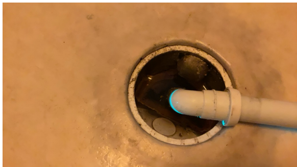
Plastsluk med vinylbelegg.
