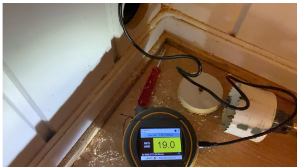
Fuktmåling i konstruksjon mot bad/vaskerom.
