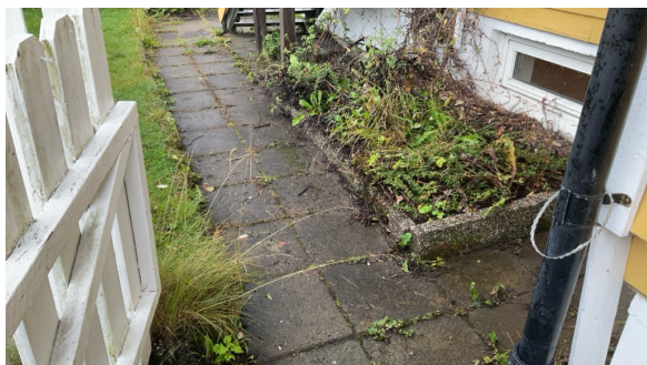
Noe lokalt fall på terreng mot grunnmur
