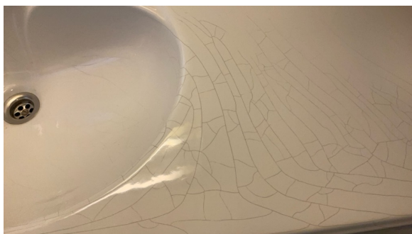
Krakelering i overflate på formstøpt vask.
