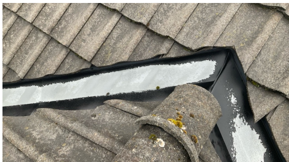
Overflatebehandlig i gradrenner flasser.
